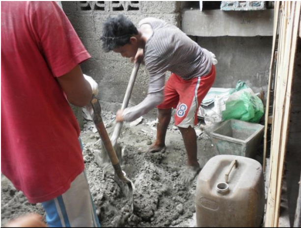
セメントを混ぜているところ
